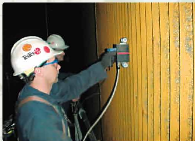
Контроль труб котлов
